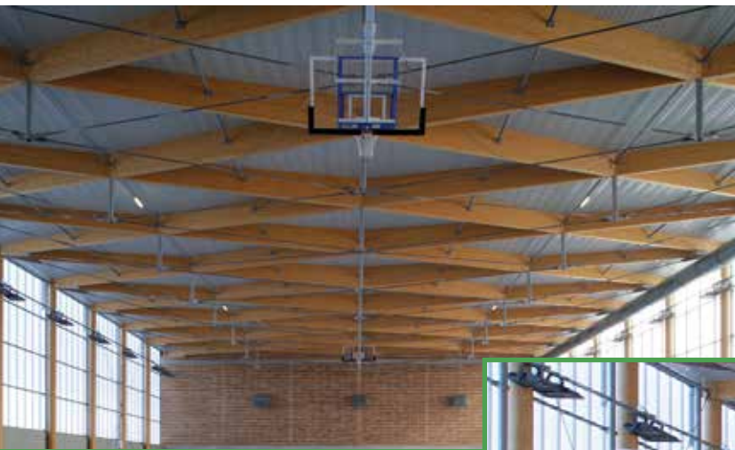
Sports Hall, Francia | Controlite Arquitecto: Gremillet
